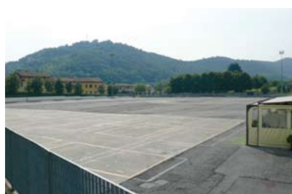
L'area del mercato da settembre oggetto di lavori di restyling
